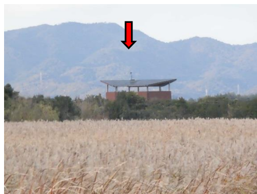
葦原から展望棟を望む（赤矢印の下にカメラ）
